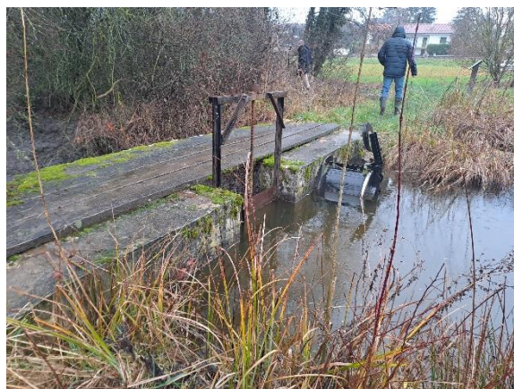
Vue de l'ouvrage aval (massif en béton, vanne et clapet anti-retour)
