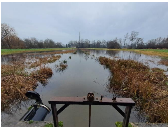
Vue depuis l'ouvrage aval (vanne fermée)
